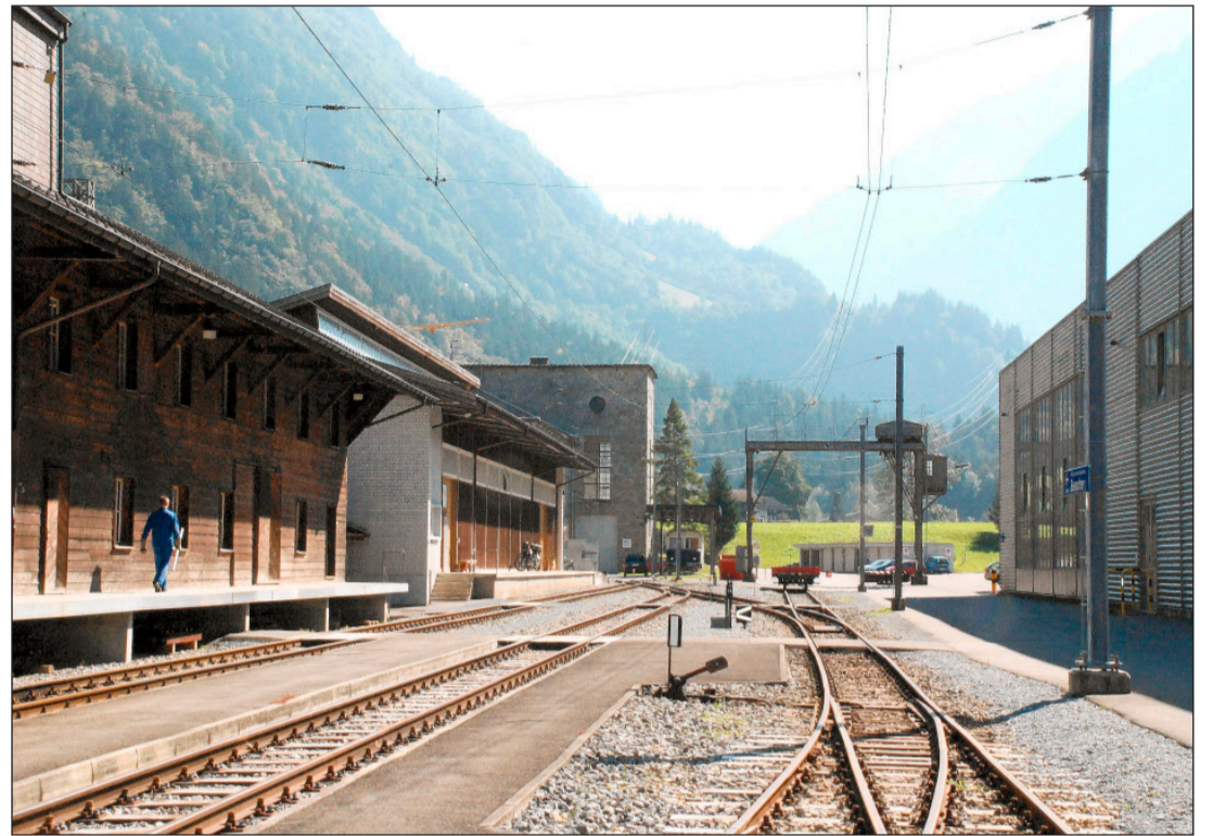
Endstation: Das Schienennetz im Oberhasli endet hier bei den Kraftwerken in Innerkirchen. Ein Student prüft, ob sie von hier geradeaus Richtung Grimselpass weiterführen soll.
